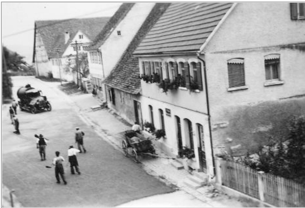
Das Gebäude-Ensemble im Jahr 1937: rechts die Metzgerei, in der Mitte der Schafstall, links das heutige »rote Haus«. FOTO: PR
